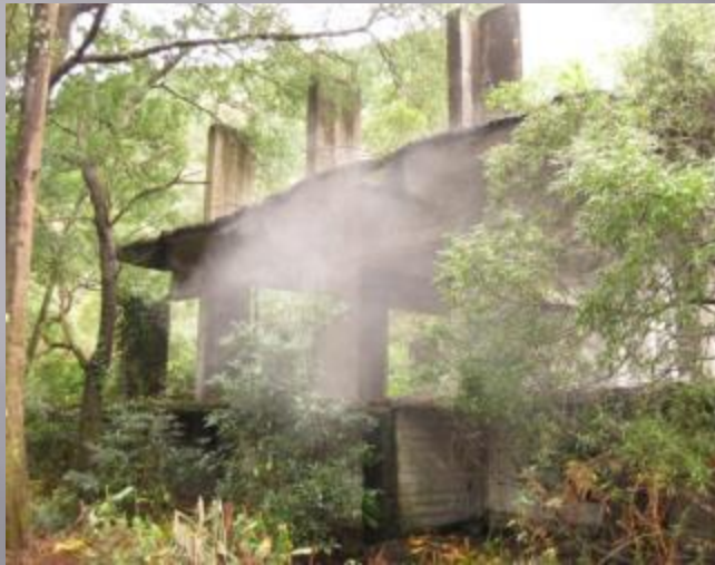
Demolição de ruínas e remoção de flora invasora
